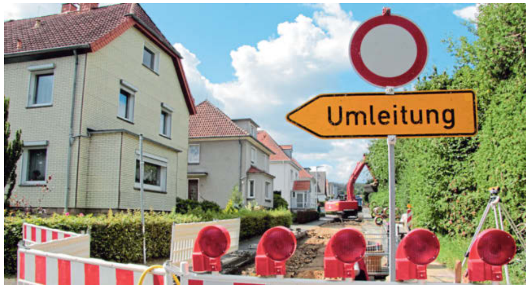
In der Wasserfurche ist ab der Krumpfen Straße derzeit kein Durchkommen. Die Stadt erneuert Kanäle, die Stadtwerke verlegen Fernwärme. FOTO: CAROLIN BROKMANN-FÖRSTER
